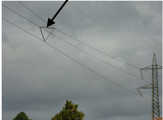
distanze ridotte fra i conduttori di fase per la riduzione dei campi elettrici e magnetici
