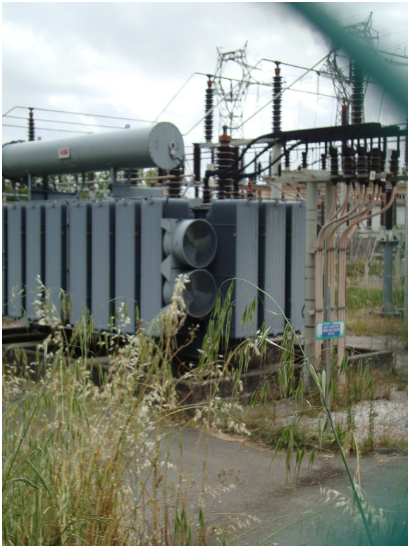
trasformatore 150 kV / 20 kV di cabina primaria
